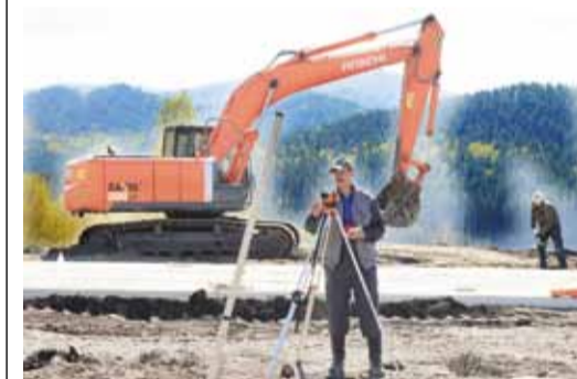
Кинут работа на месте будущей ГРС
